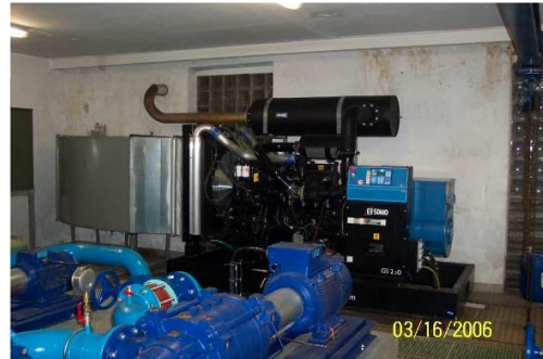
Groupe électrogène
