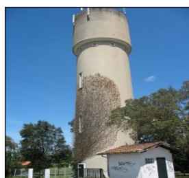
Château d'eau Cap de Hé
