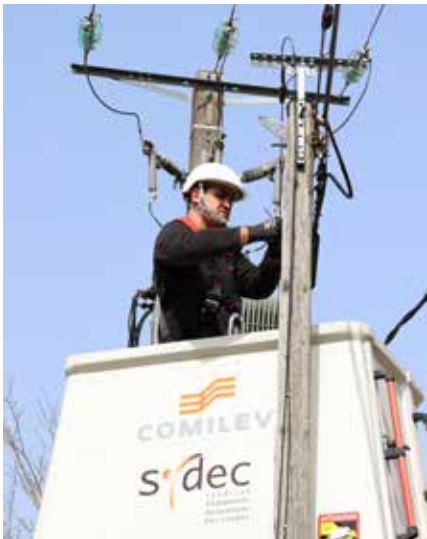
Fernando De Abreu Lopès, du service Maintenance de l'éclairage public, réalisant un raccordement optique à proximité d'un réseau sous tension.
