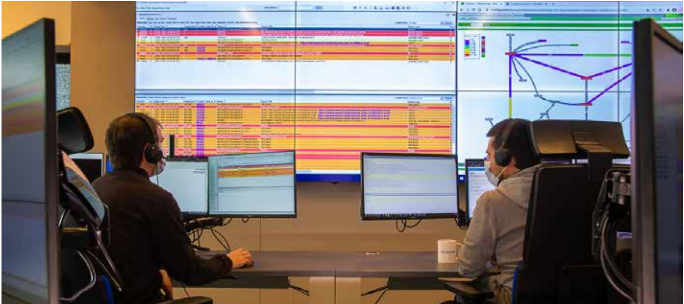
Centre opérationnel de supervision du réseau, Axione - Pau
