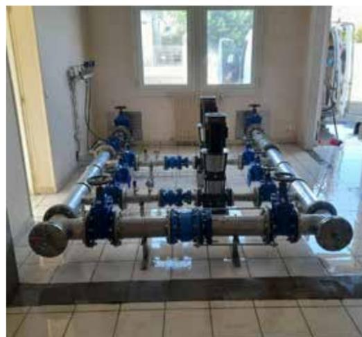
Interconnexion en eau potable : création et pose d'un surpresseur d'eau potable avec 2 pompes.
