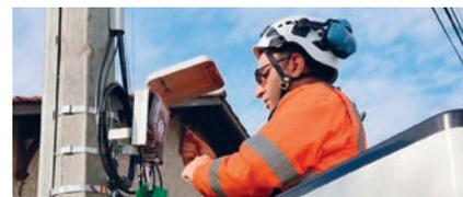
Enfin, la fibre est replacée dans sa cassette, un compartiment spécifique au sein du boîtier. Ce dernier peut être installé soit en souterrain, soit en aérien.
