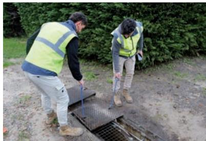
Avant la pause : l'ouverture et le contrôle d'une chambre télécom située sur l'avenue Deyres à Seignosse. Guilian et Mathieu effectuent des vérifications sur les équipements situés à l'intérieur. Ils contrôlent notamment le passage des câbles de fibres optiques ainsi que la conformité des PGC (Plan Génie Civil).
